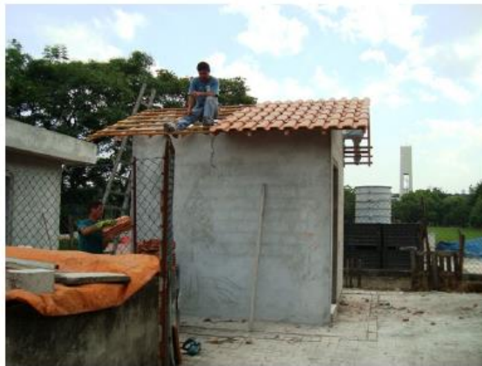
Figura 23 - Montagem do telhado cerâmico
