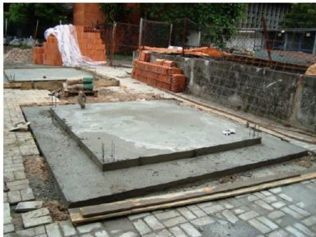
Figura 20 - Fundação tipo radier
