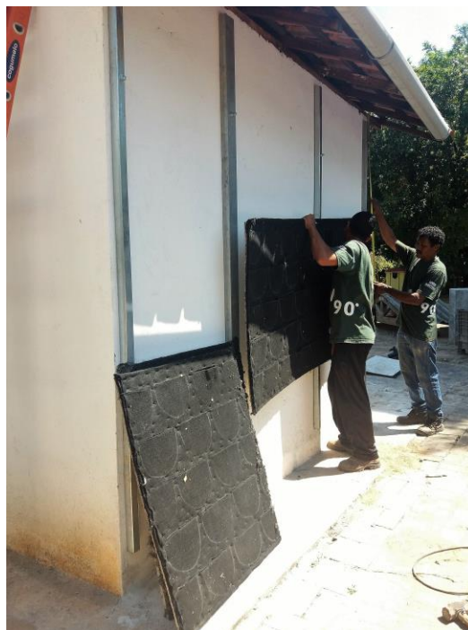
Figura 25 - Fixação das Placas Pré Montadas às Barras Metálicas
