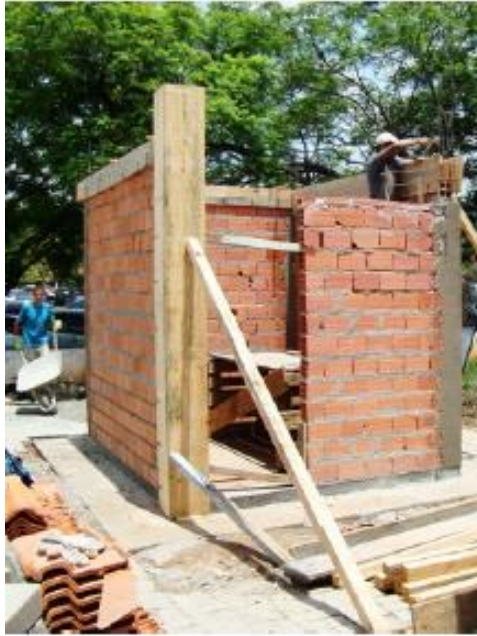
Figura 22 - Pilares Estruturais
