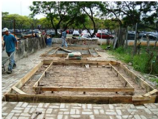
Figura 19 - Gabarito para fundação
